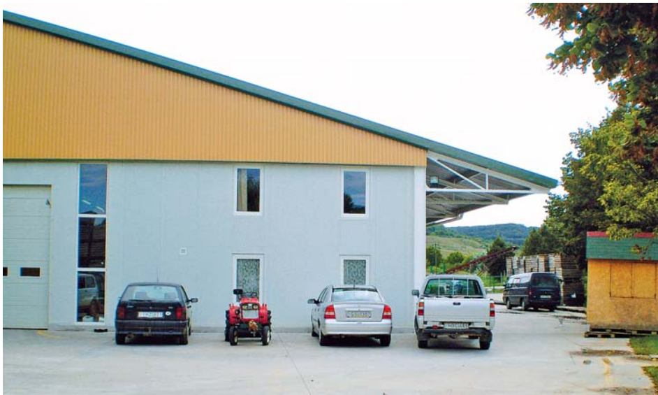
A szövetkezet új épülete
